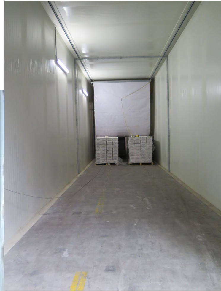
Ερμητικά κλειστός θάλαμος απεντόμωσης.
